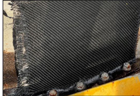
ARC CFW-CR \은 준비 후 파손 부위에 적용되었습니다.
