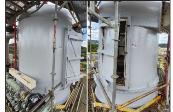
ARC CS2는 CFW-CR수리 위에 탑코트로 적용되었습니다.
